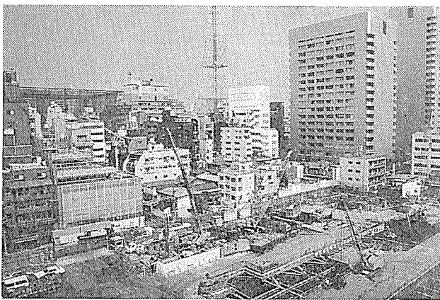
写真—1 施工状況（全景）
