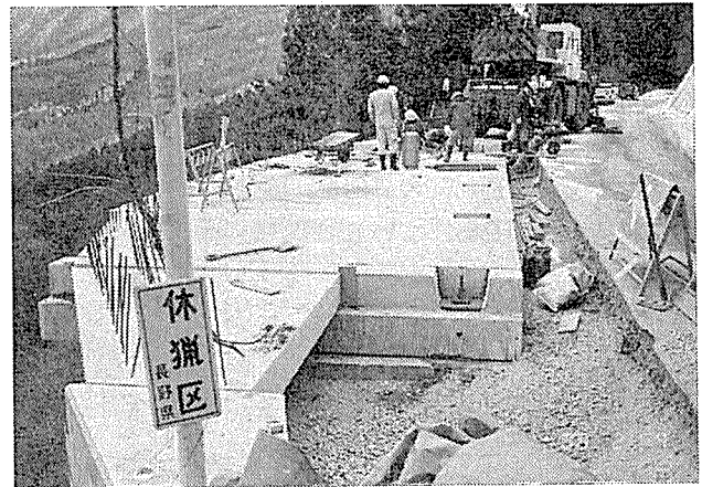
写真-6 主桁、床版の設置
