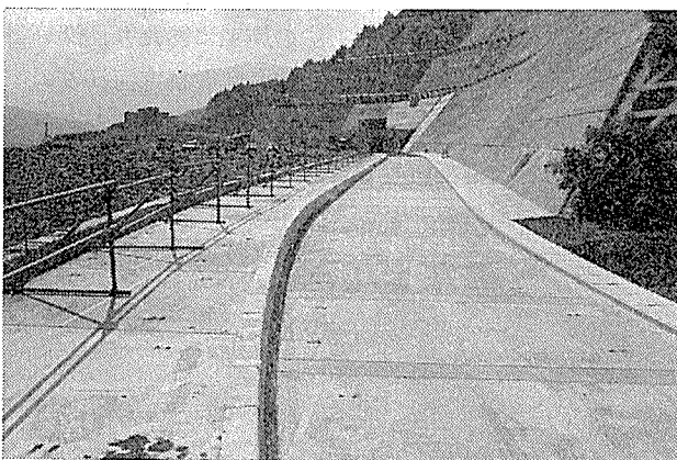
写真—3 部材設置完了
