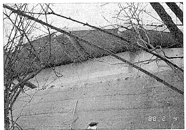
写真-7 張出し状況
