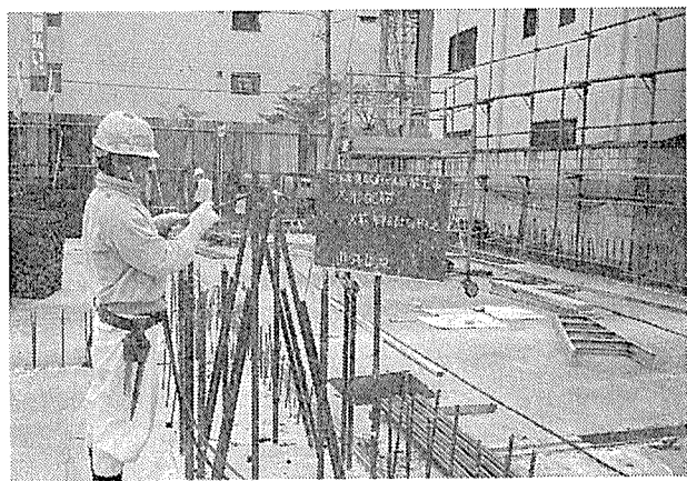
写真-2 X形筋継手部切りそろえ
