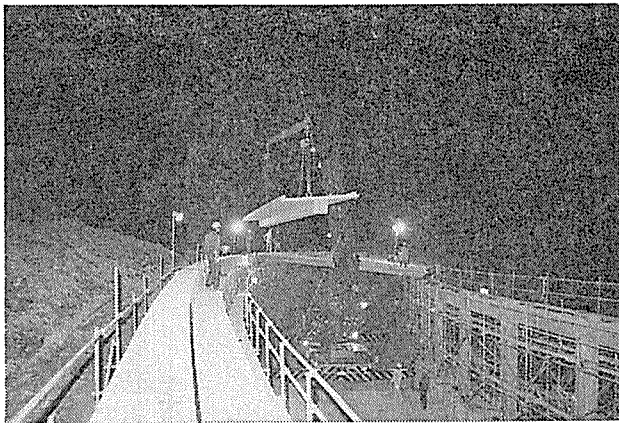
写真-11 主梁の架設
