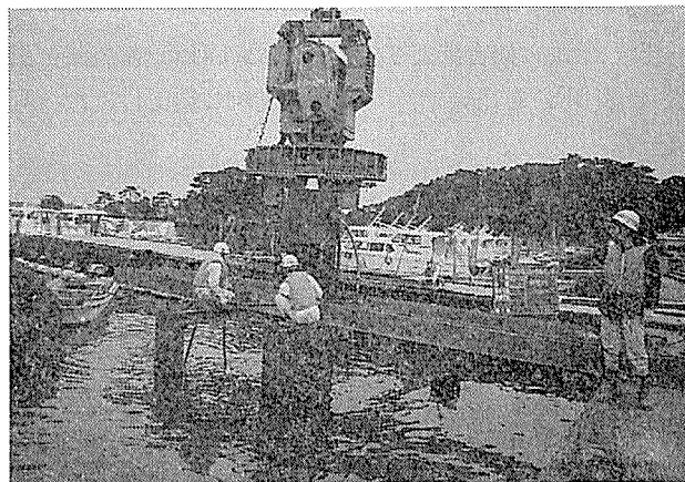
写真—8 ドルフィン部施工（杭打ち状況）
