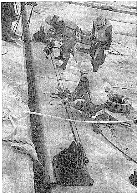
写真—6 海上接合工
