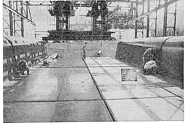
写真三 底型枠組立て状況
