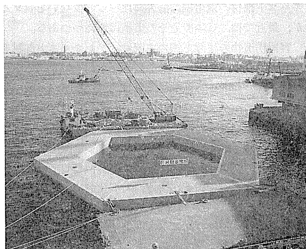
写真—20 六角ポンツーン
