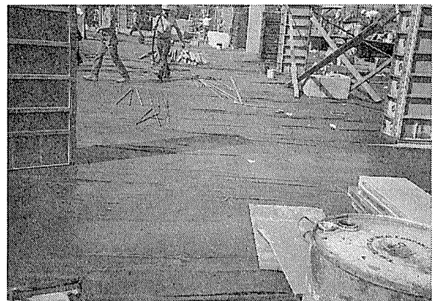
写真—11 養生状況
