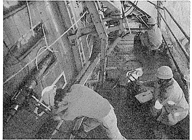
写真-9 PC 鋼材緊張工事
