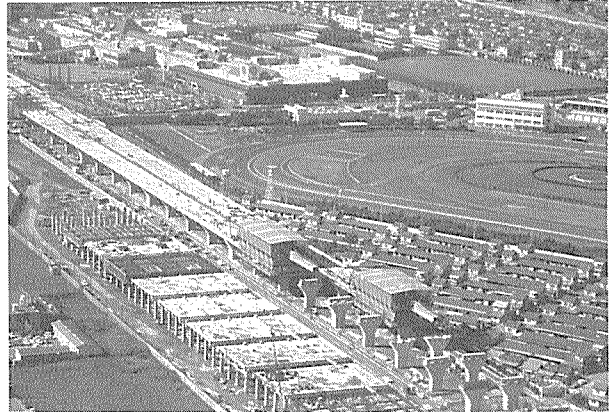
写真-6 ゲリュストワーゲン工法
