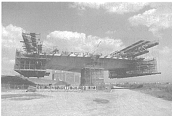
写真-1 施工状況
