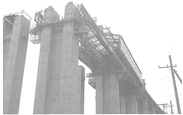
写真-1 サポートタイプ移動支保工
