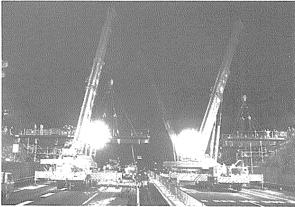
写真-1 300 t 油圧式トラッククレーン(東名改築工事・跨道橋解体)
