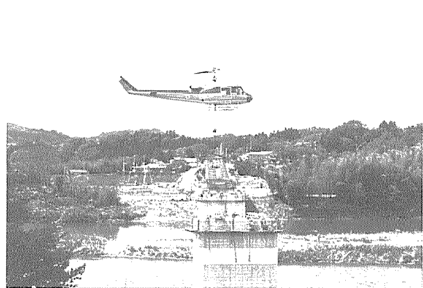
写真-7 ヘリコプターによる支承据付け
