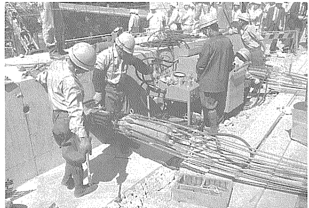
写真-3 ロアリング用ジャッキ・ポンプ
