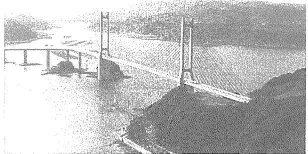
写真-1 呼子大橋
