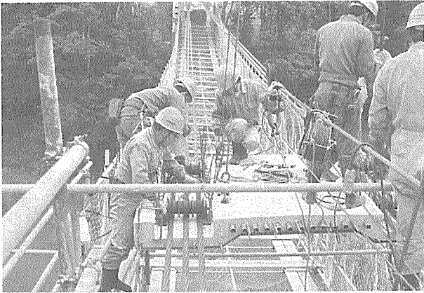
写真-2 移動用ローラーの取付け
