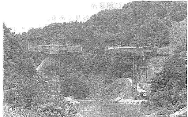
写真-2 張出し施工
