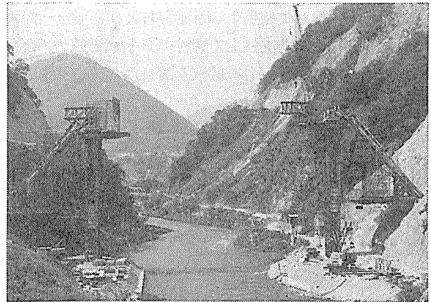
写真-5 メラン材架設状況
