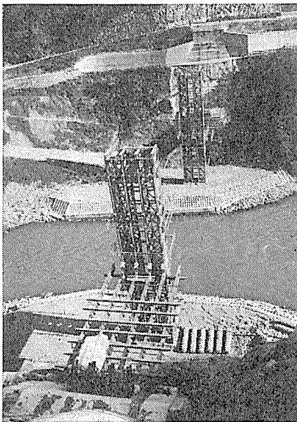
写真-4 仮支柱設置状況
