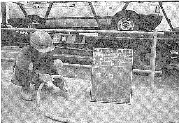
写真-3 裏込めグラウト充填状況
