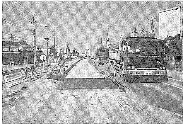
写真-4 施工状況
