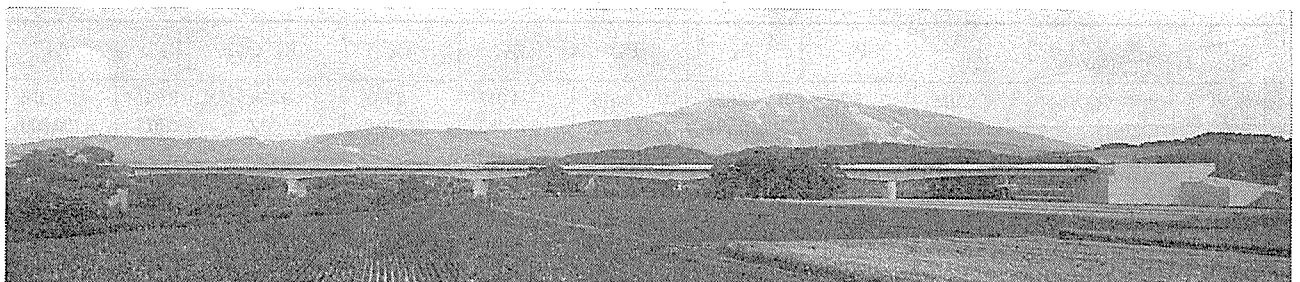
写真-1 石狩川橋 (A 1 橋台側)
