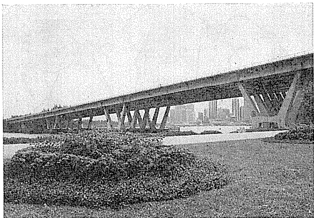
写真—1 ベンジャミンシアース橋全景
