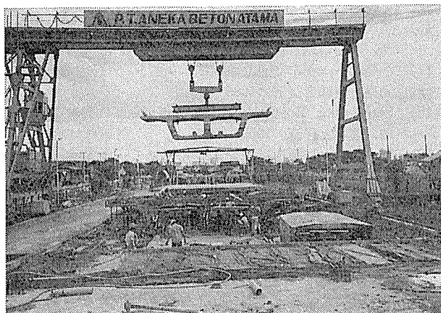
写真-18 主桁ブロック製作工場
