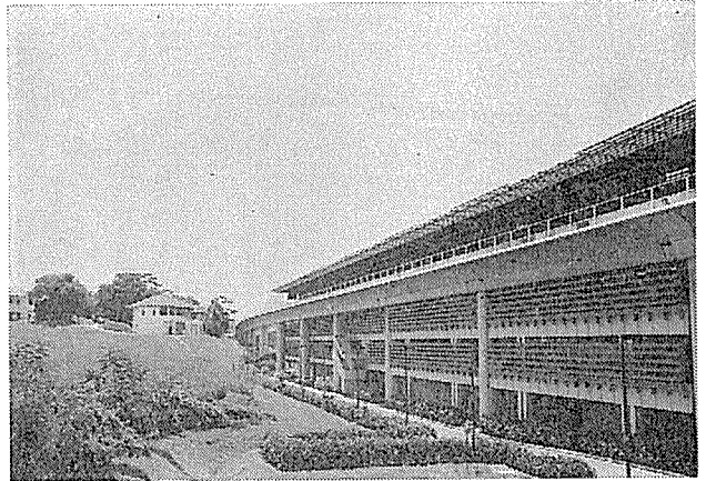
写真—9 MRT 駅舎部
