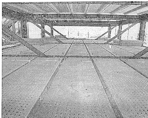
写真—7 π スラブリの敷設状況
