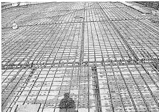
写真—5 π スラブ上面の配筋
