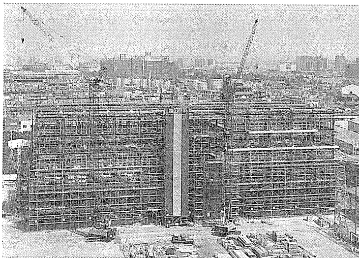
写真—10 全体外観（鉄骨建方完了）
