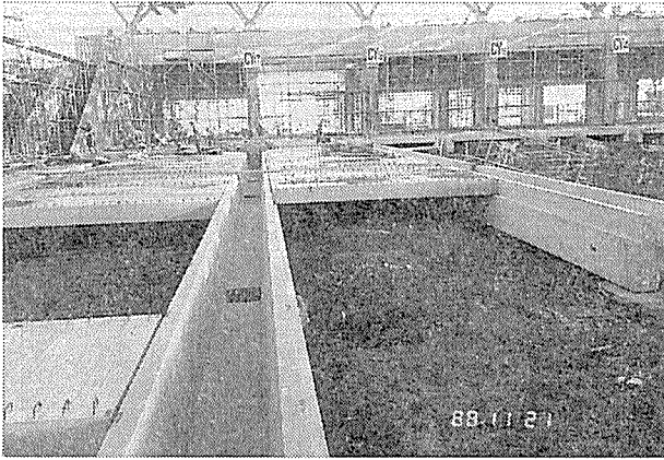
写真—3 地中梁U字溝と土間用 PC 床版
