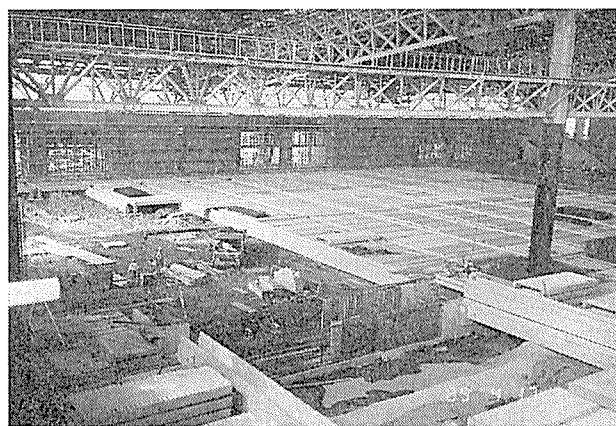
写真-2 土間面の PC 床版のセット
