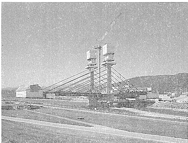
写真—1 施工中全景（現況）
