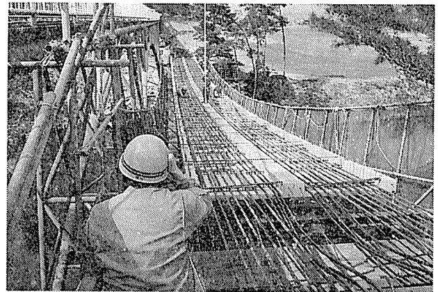
写真-3 プレキャスト版架設
