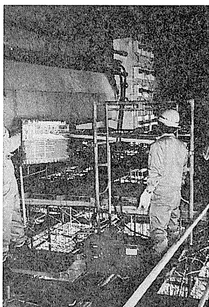
写真—1 縦締め緊張状況
