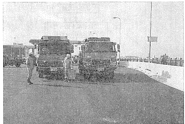
写真-2 実橋載荷試験
