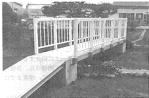
写真-4 ネフマックを使用したPC床版歩道橋
