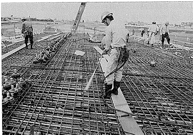
写真-3 柱頭部の施工
