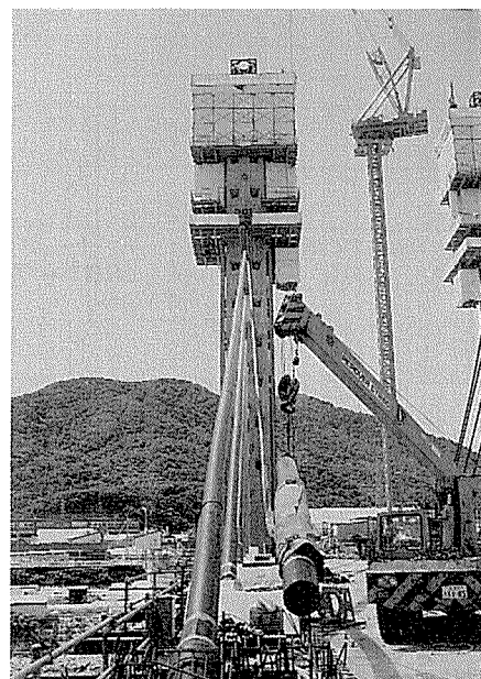
写真-15 PE管架設
