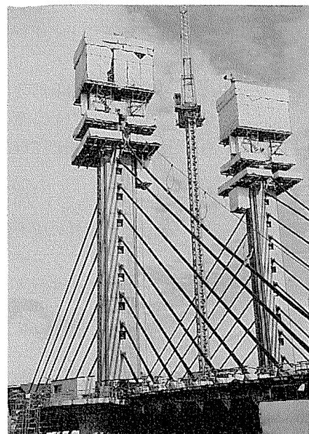
写真-10 エレクション装置架設
