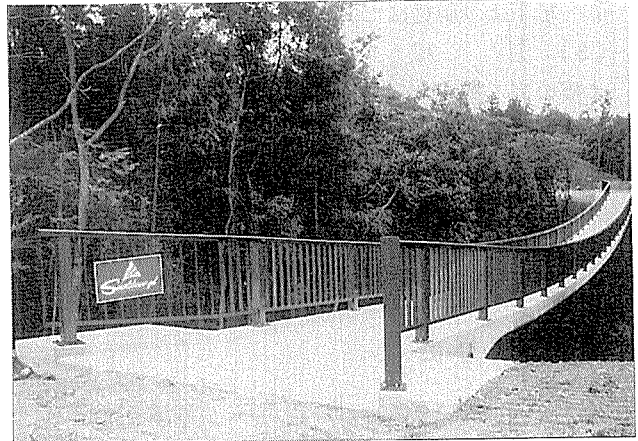
写真-1 完成後の吊床版橋
