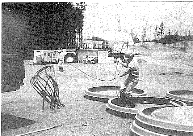
写真-13 搬入後のカーボン繊維 FRP ロッド
