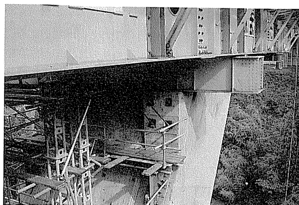
写真-14 鋼製ブラケットとコンクリートブラケット
