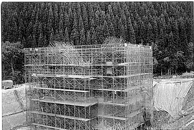
写真-3 基礎頭部 施工状況
