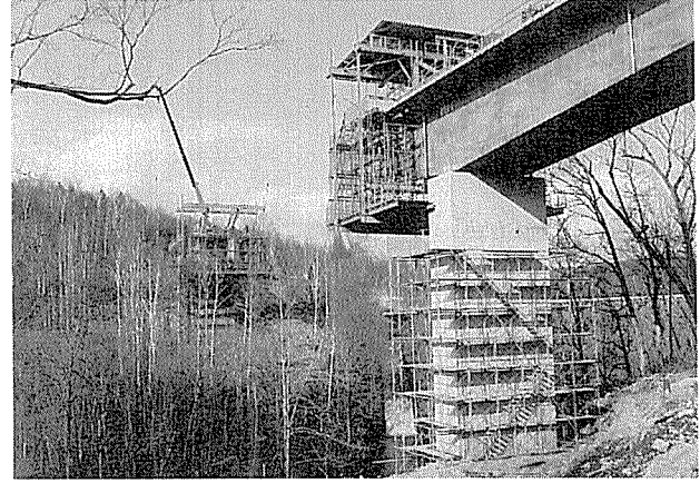
写真-5 張出し施工
