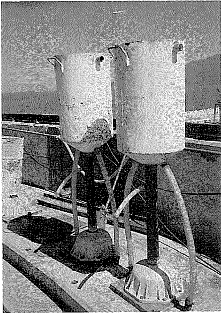
写真-5 ヘッダータンク取付け状況
