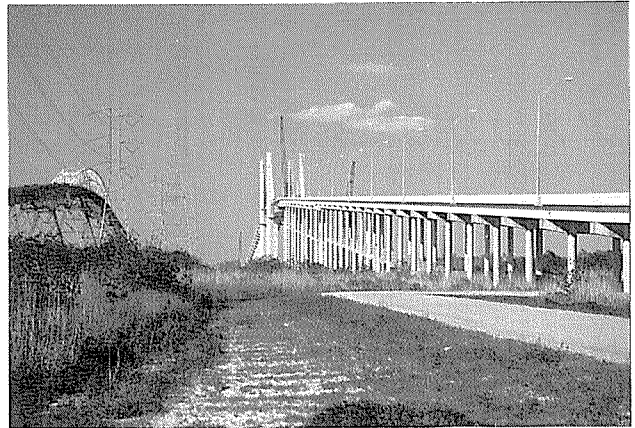
写真-3 ネイチェスリバー橋
