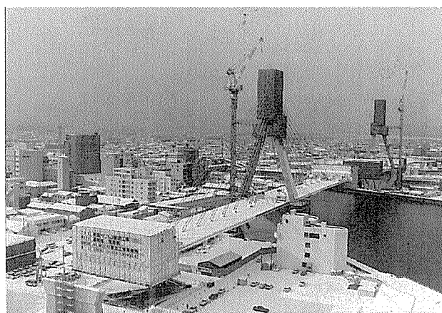
写真-7 工事全景（平成2年12月）
