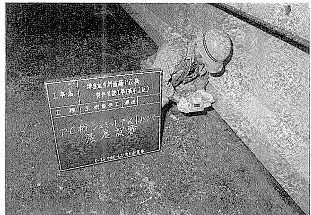
写真-3 PC 桁の打点
