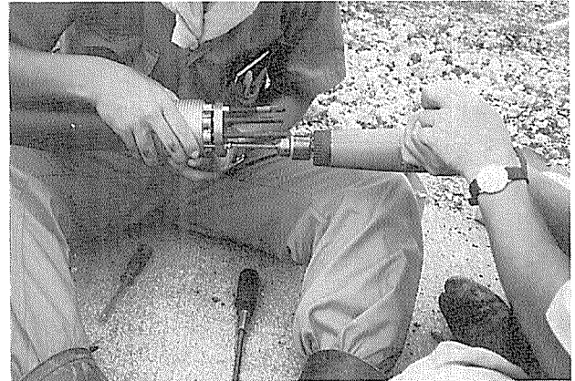
写真-7 リテーナプレートによるクサビの押込み
