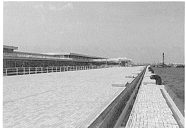
写真-5 インターロッキング舗装
