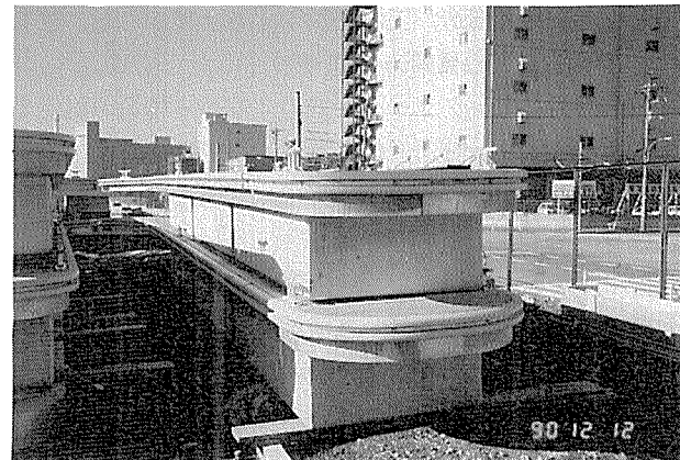
写真-9 サブポンツーン
