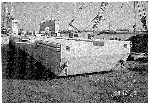
写真-6 防舷材取付け状況
