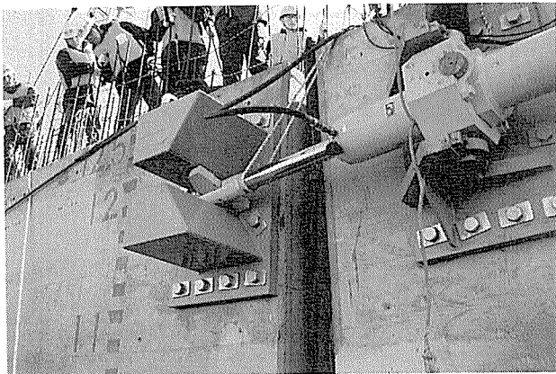
写真-2 試験時の引寄せジャッキの状況
