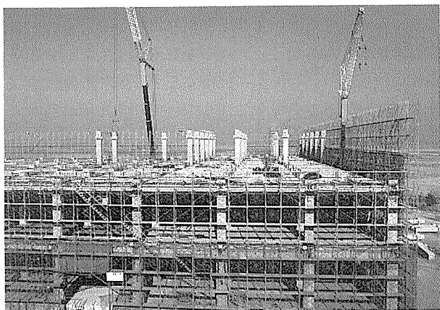
写真-2 施工中の全景
