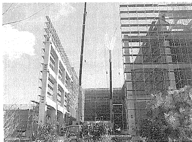
写真-5 ラック棟柱高さ 26.75 m の柱の自立
