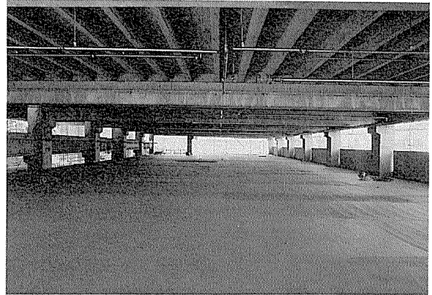
写真-9 トップコンクリート打設後
