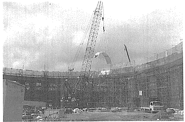
写真-7 PCa版の架設
