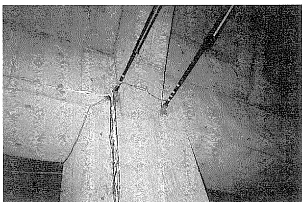
写真-9 アンボンドPC鋼棒のセット状況
