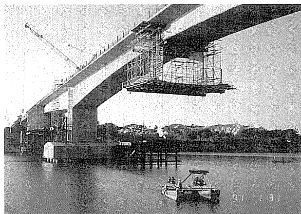
写真-9 中央ヒンジと側径間支保工
