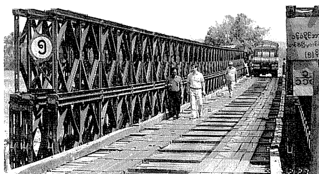
写真-2 仮設ベイリートラス橋
