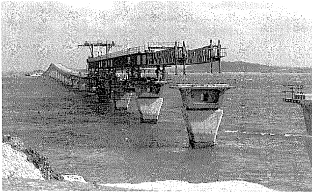
写真-2 架設中の池間大橋
