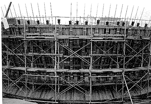
写真-4 外型枠施工状況
