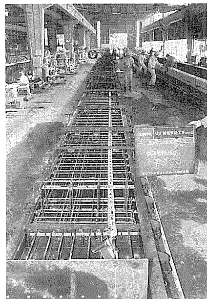
写真-1 PC板の製作状況
