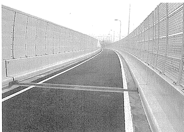
写真-7 連続桁橋の例 (首都高速道路公団)
