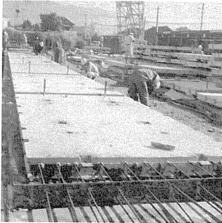
写真-1 プレキャスト床版の製作
