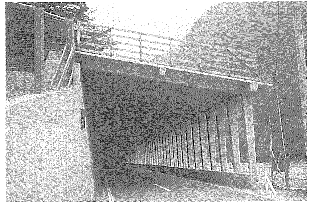
写真-1 PC スノーシェッド（逆 L 型）
